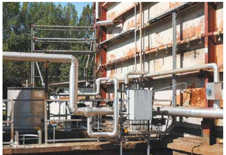
Új gőzrendszer került telepítésre és az új irányítástechnikai hálózatot is korszerű megoldásokkal kiviteleztek
