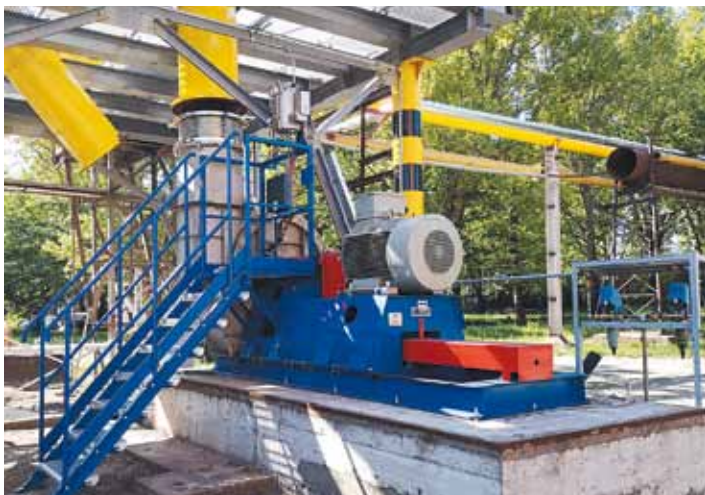
A felújított 2. sz. nyomásfokozó ventilátor már a helyén áll, gépészeti és villamos bekötése folyamatban van
